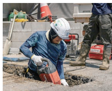
道路掘削作業の様子
