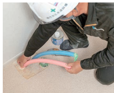
屋内配管作業の様子
