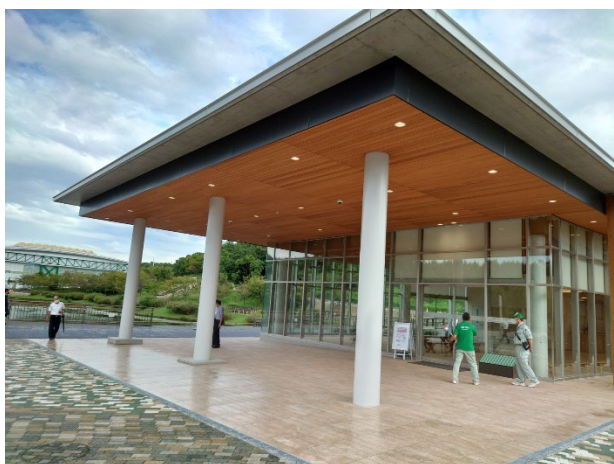
①西口休憩所入口
